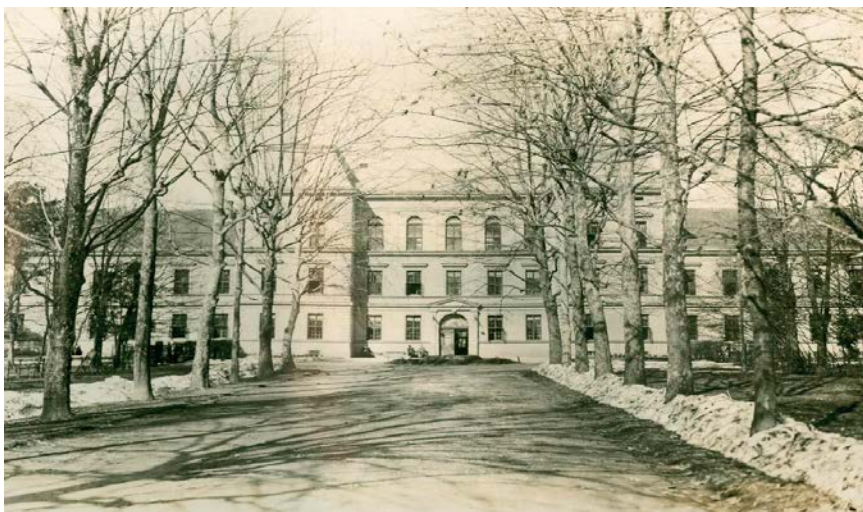
Slika 10. Glavna zgrada bolnice (preuzeto iz KPV-a, 2014.)
